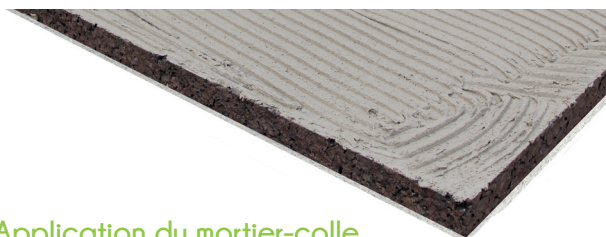
Application du mortier-colle avec une spatule dentelée
