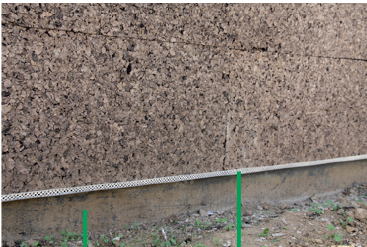
Profil de socle aluminium en U
