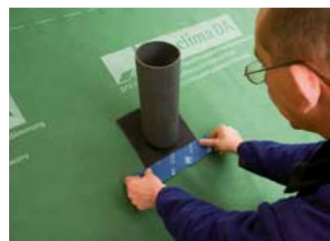
ROFLEX 50, ROFLEX 100 Manchettes pour conduits d'un diamètre de 50 à 90 mm et de 100 à 120 mm
